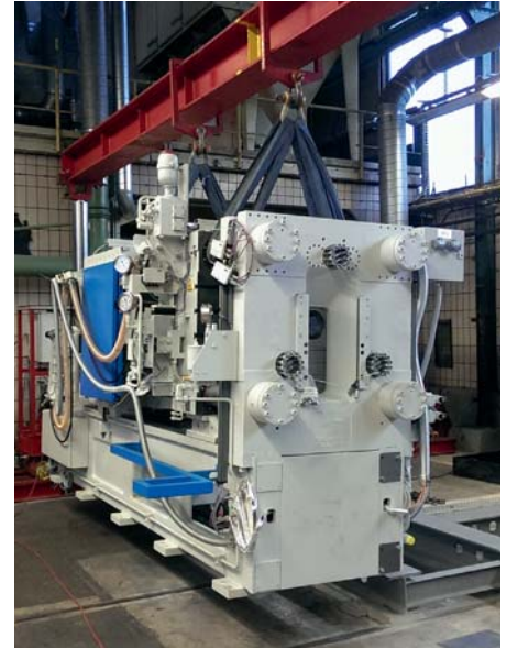
Aufbau der neuen Druckgießmaschine DAK450-40 Vacural der Firma Frech in der Gießhalle.
